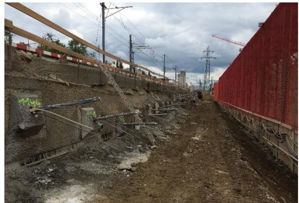
rückverankerte Spritzbetonwand unterhalb Linie 260
