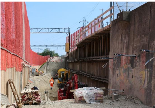
Rühlwand unterhalb Linie 220
