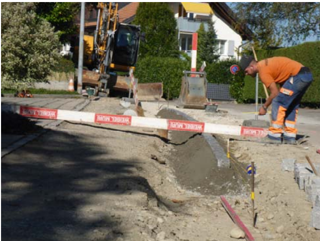
Neuer Bundstein auf Länge 55 m im Radius versetzt
