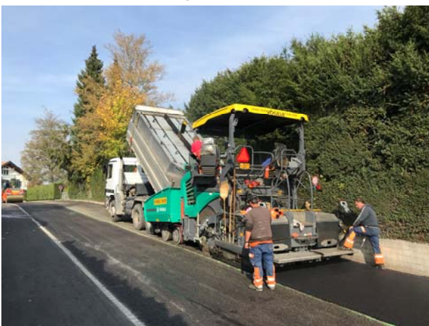
Flächiger Belagseinbau mit Grossfertiger
