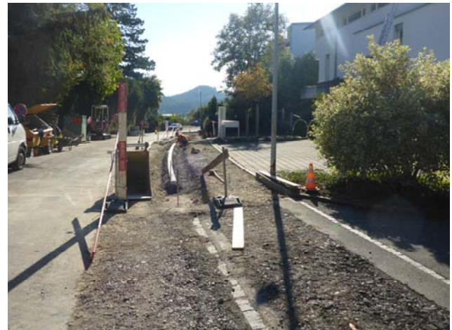
Aufrechterhaltung aller Privatzufahrten während Bauzeit
