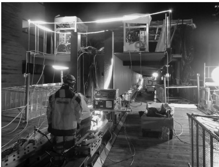
Verschub der Brücke
