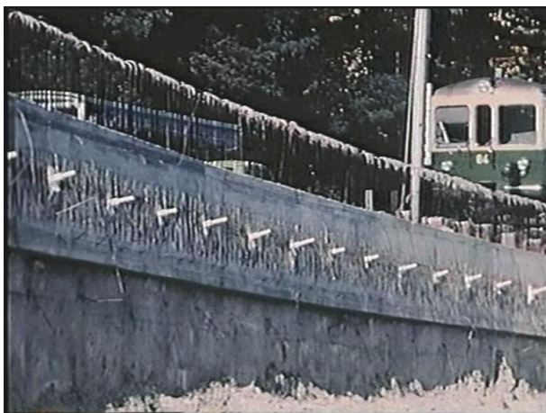
Verankerungsriegel im Bauzustand 1967
