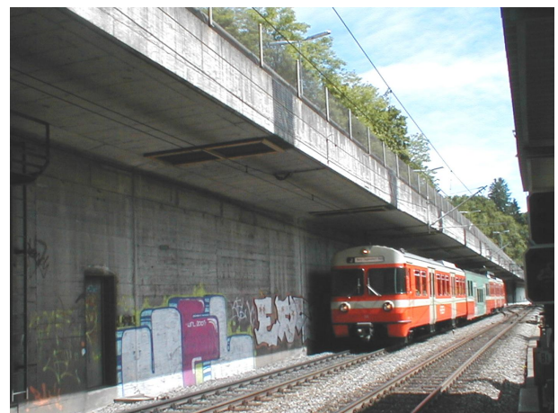
Konsole Tiefenaustrasse mit Stützmauer
