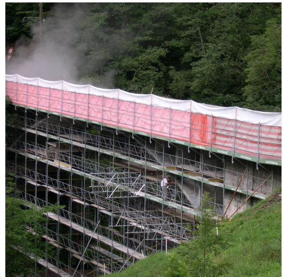
Eingerüstete Traubachbrücke mit Fussgängersteg
