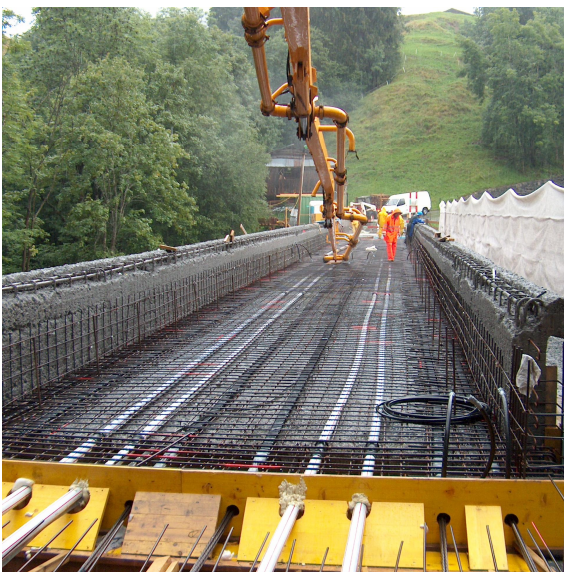
Vorbetonierung im Brückentrog
