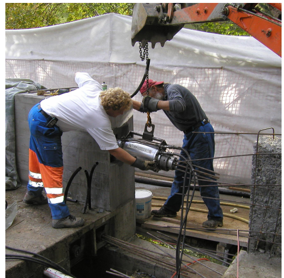
Vorspannung des Überbaus
