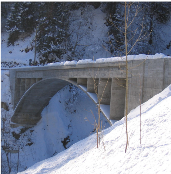
Traubachbrücke nach der Instandsetzung
